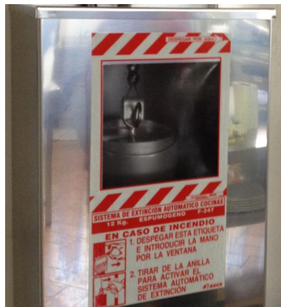
Foto: Detalle armario en acero inoxidable del equipo automático y manual CROCADE-S, sistema de activación manual.
