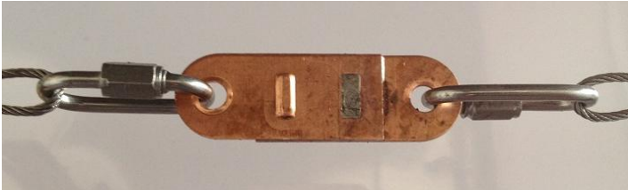
Foto: Detalle detector térmico equipo CROCADE-S, 110°C.
