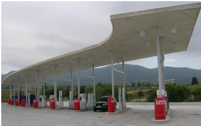
Foto: instalación de equipo DEXA.
